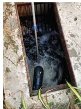
ภาพถ่ายที่ 2.2-64 ตะแกรงดักขยะที่บ่อตรวจสอบสภาพน้ำ
