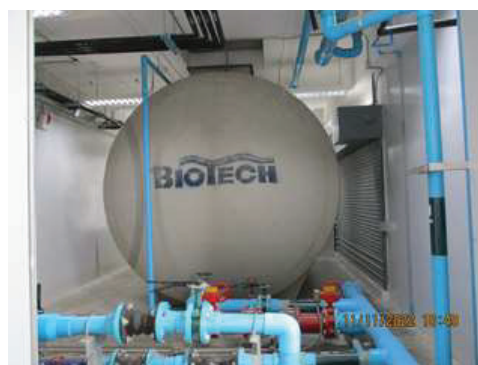
ภาพถ่ายที่ 2.2-60 ถึงสำรองน้ำใช้บนหลังคา
