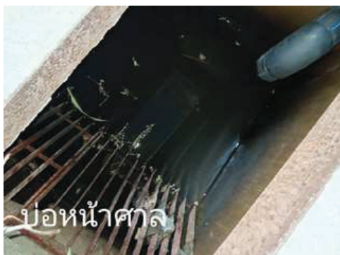
ภาพถ่ายที่ 2.2-64 ตะแกรงดักขยะที่บ่อตรวจสอบสภาพน้ำ
